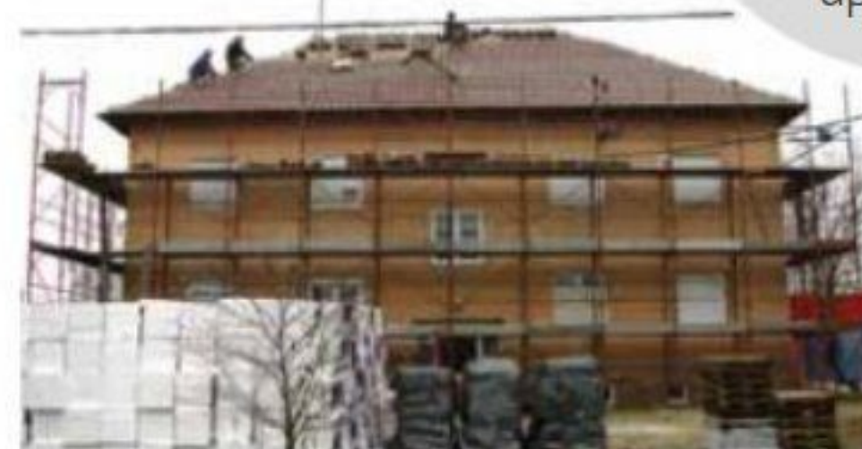
Zgrada u M. Središću, trenutno u fazi energetske obnove
